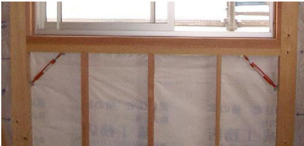
開口部耐震構造補強部材 + 制震ダンパーの取付イメージ写真
