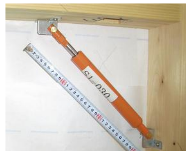
制震ダンパー取付部拡大写真
