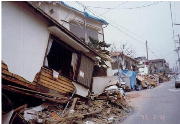
兵庫県南部地震による木造家屋の倒壊
